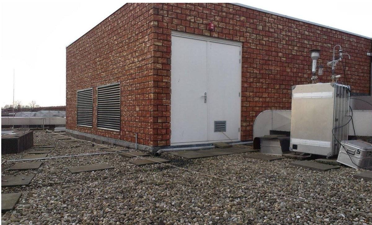
Figuur 4. Meetopstelling op het dak van de Prinses Marijkeschool. Links van de meetopstelling het ketelhuis waarin het rooster zichtbaar is waardoor de buitenlucht wordt aangezogen (NB het andere rooster voert lucht aan voor de naastgelegen school die zich onder dezelfde kap bevindt.)
